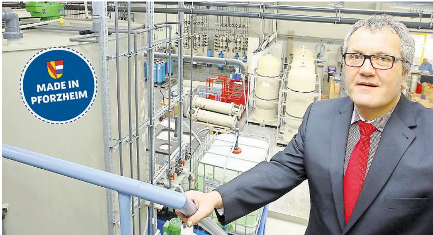
Firmenchef Bernward Groß hat die Abwassertechnik voll im Griff.
